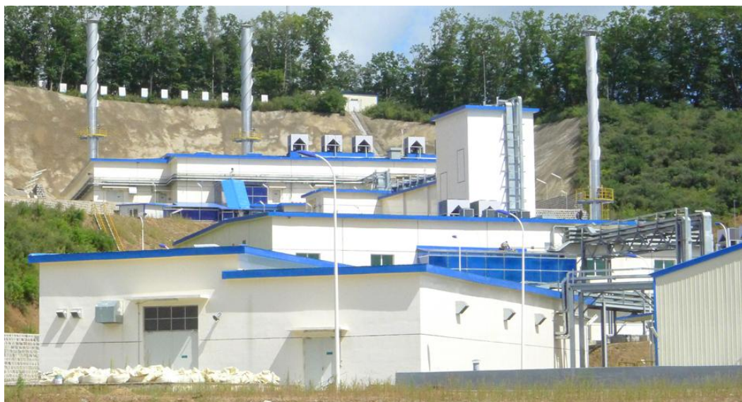
图 20 吉林敦化哈尔巴岭日遗化武挖掘回收设施
