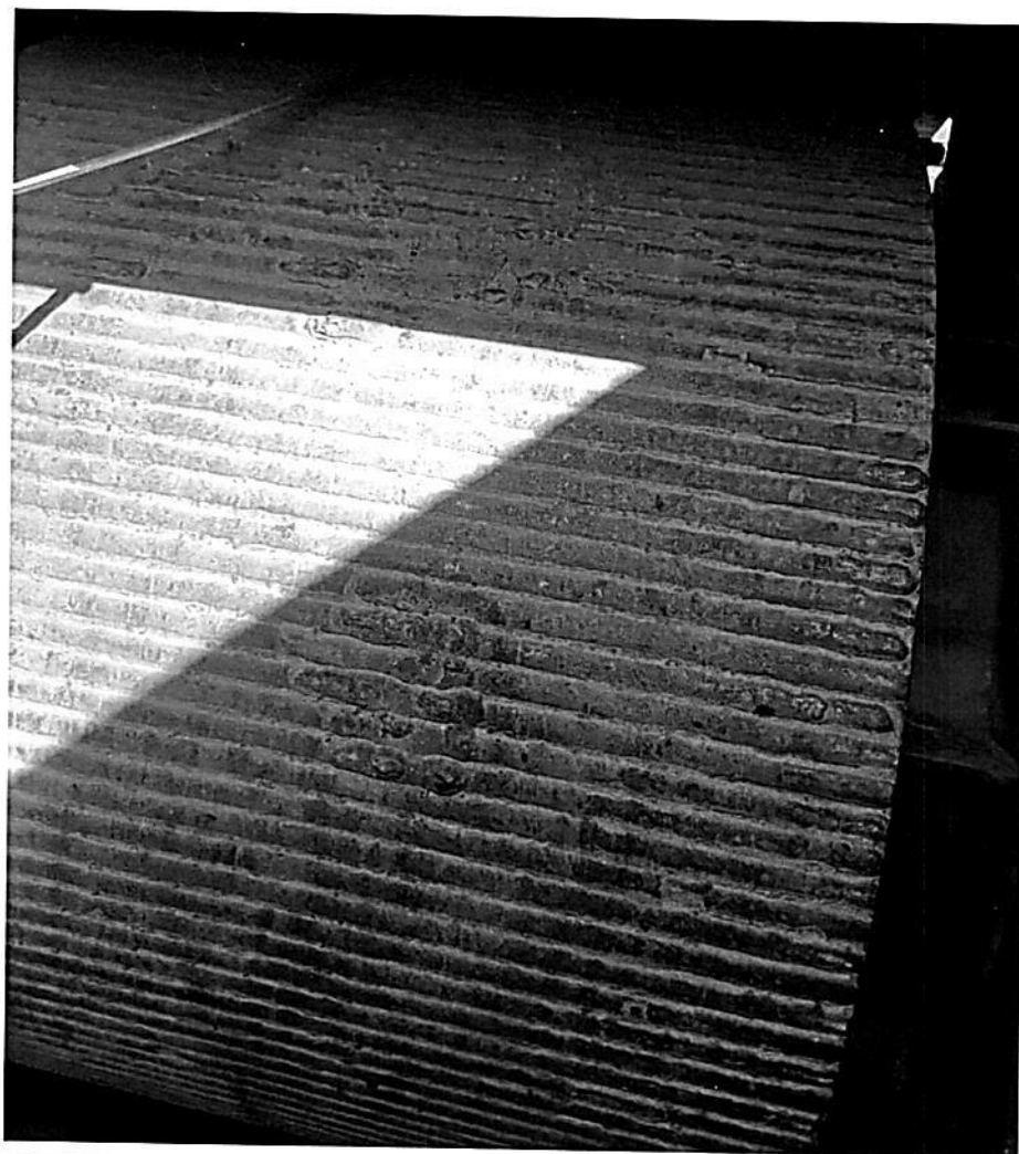
现场测量辊压机实际尺寸（G1410）
